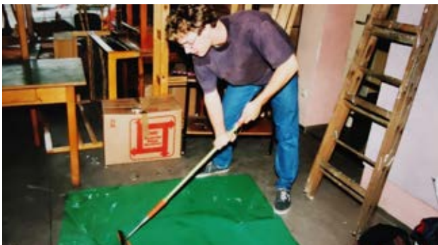
Aufräum- und Reinigungsarbeiten
